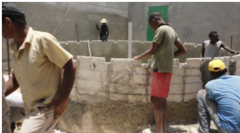
Cisternas em construção
