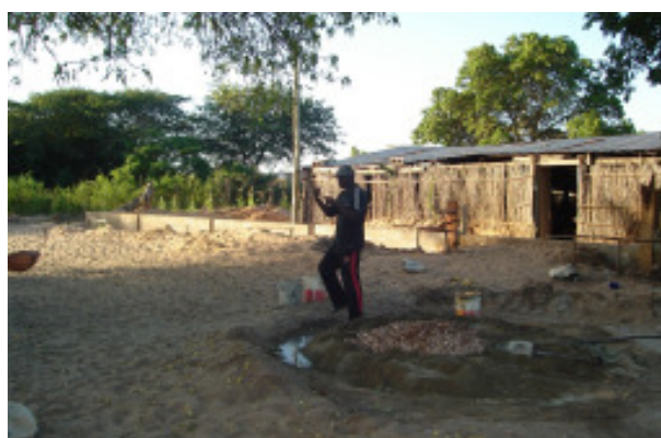
Obras de uma nova igreja
