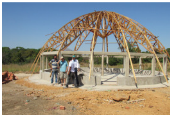
A capela xavante em construção
